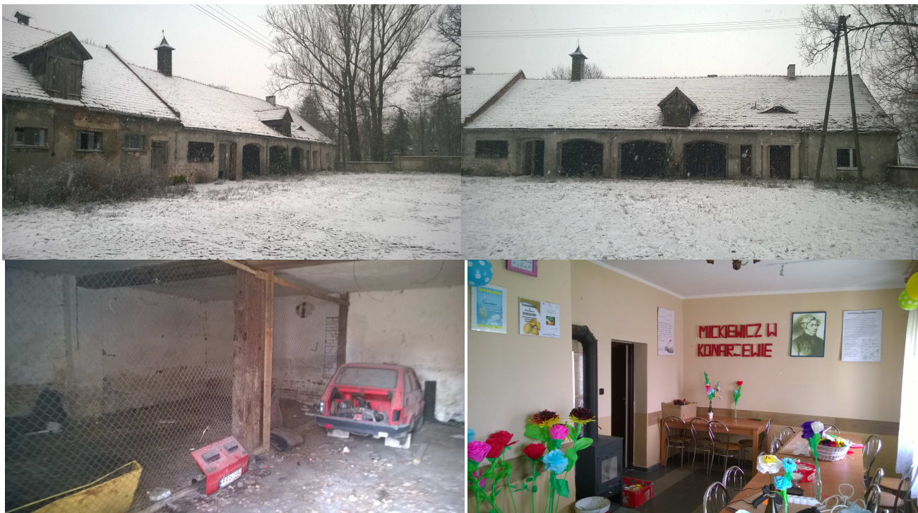
12. BUDYNEK ADMINISTRACYJNO - BIUROWO - GOSPODARCZY (D-16-115)
