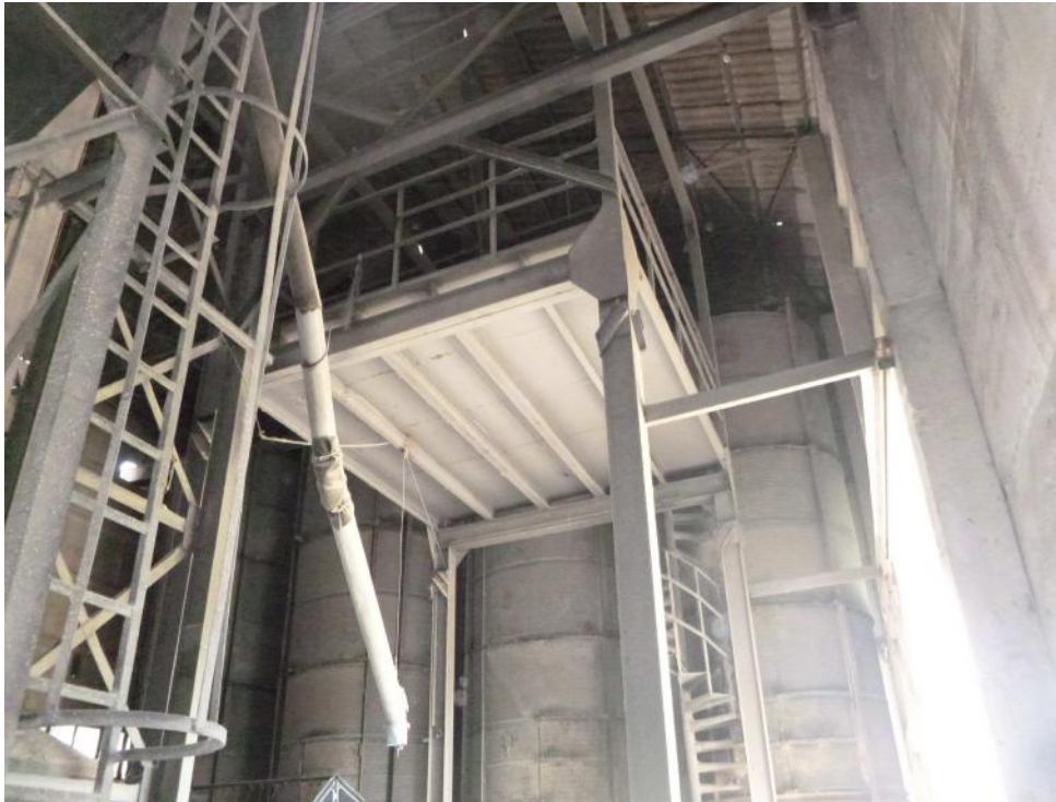
fot. 32 ( konstrukcja platformowa )
