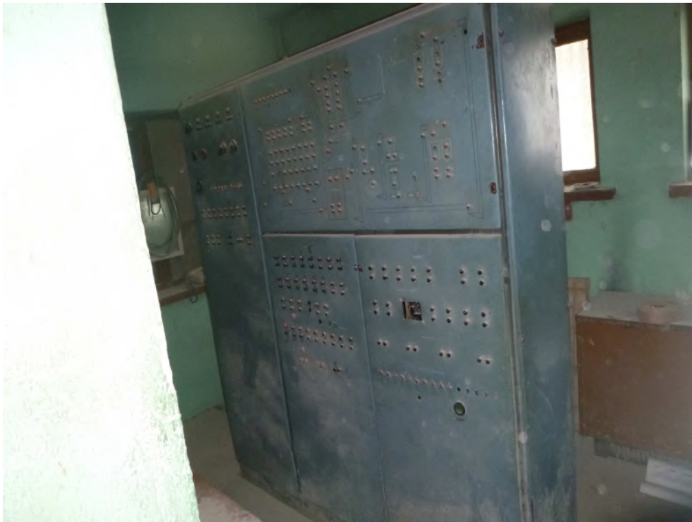
fot. 35 ( szafa sterownicza )
