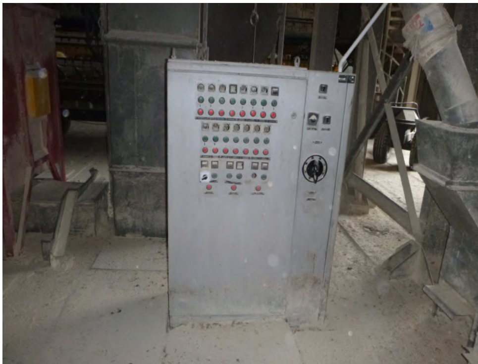
fot. 36 ( szafa zabezpieczająca )
