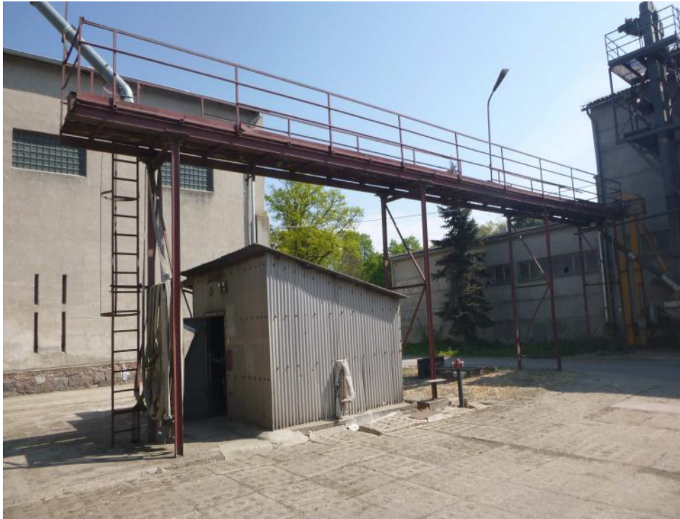
fot. 1 ( napowietrzna linia transportowa korytowa o napędzie łańcuchowym )
